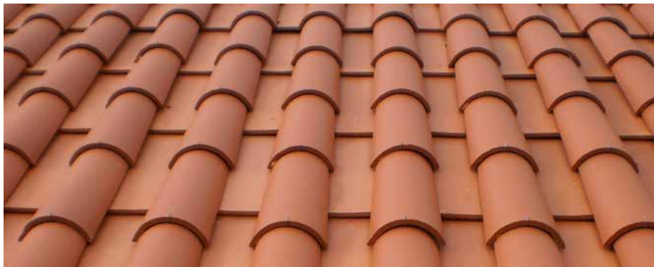
Aplicação da telha romana
