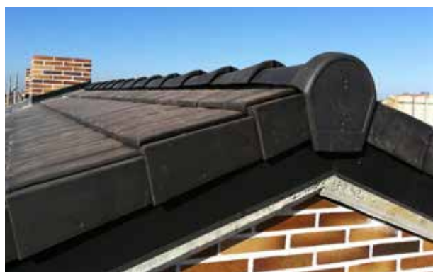
Pormenor do remate da empena da telha
