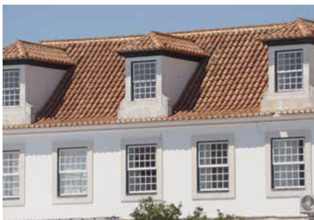
Revestimentos em zonas singulares: trapeira e claraboia
