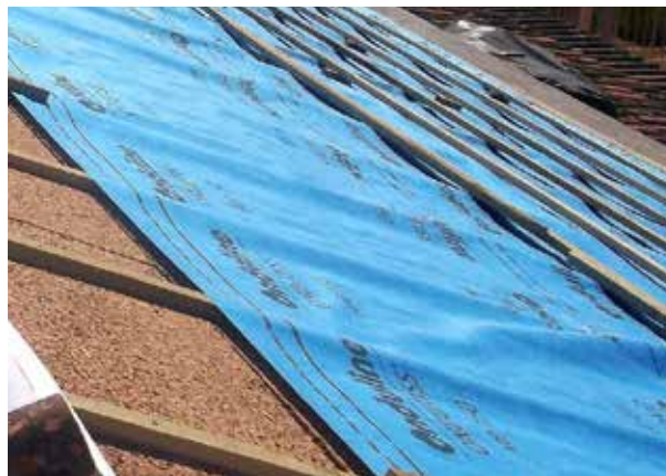
Exemplos de aplicação de barreira permeável ao vapor e impermeável à água com ripado e contra-ripado. (Imagens cedidas por DGPC)
