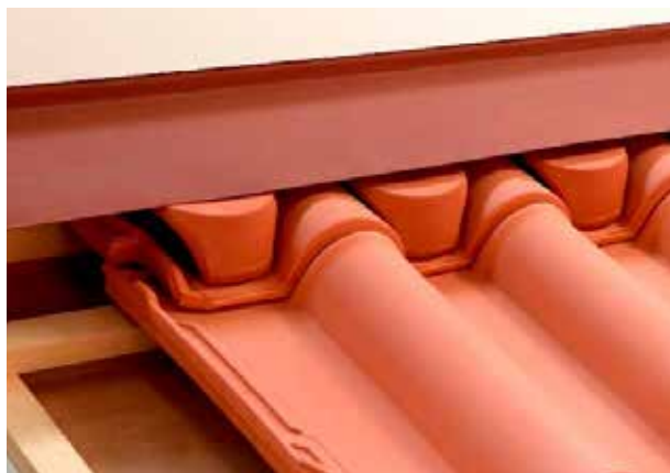
Remates do telhado com parede emergente longitudinal ao plano da vertente
