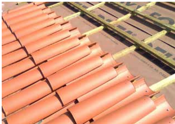
Exemplos de aplicação de barreira permeável ao vapor e impermeável à água com ripado e contra-ripado. (Imagens cedidas por DGPC)
