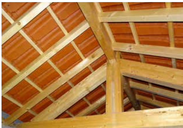
Assentamento em ripa de telha lusa e grampeamento de telha canudo
