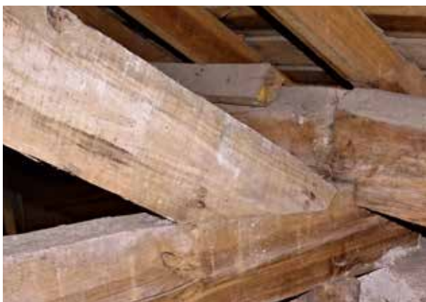
Ligação perna-linha do tipo simples
