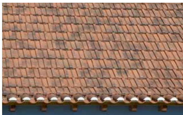
Telha marselha com beirado
