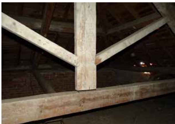
Asna com linha contínua sem ligação ao pendural
