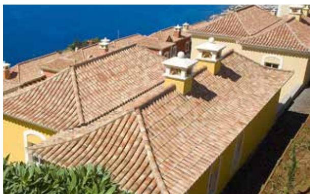
Vista geral de telhado com telha canudo
