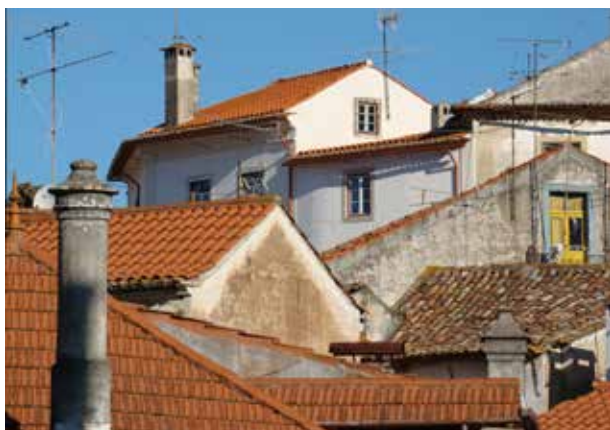
Inclinação semelhante em edifícios vizinhos
