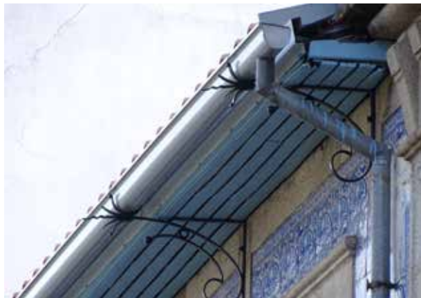
Algeroz exterior (metálico) e interior (pedra)
