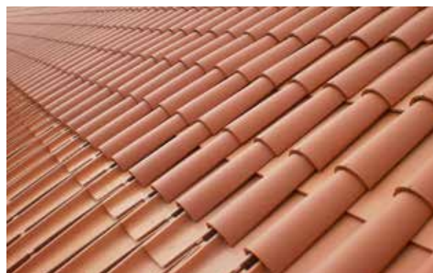
Pormenor de fixação de telha romana
