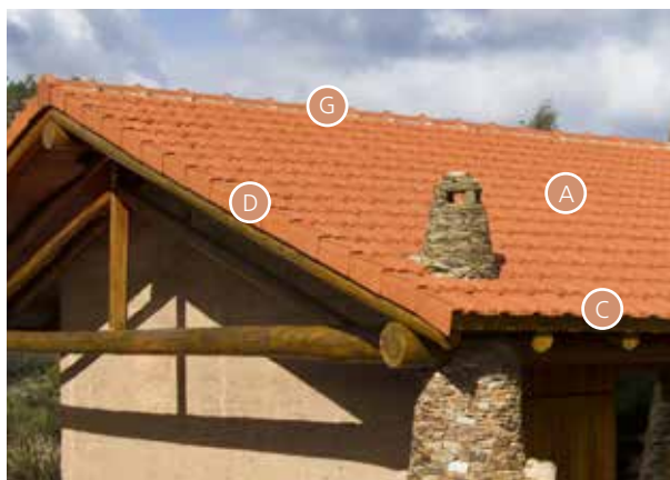
Remate lateral de empena (D), cumeeira (G), Água mestra (A) e beiral (C)
