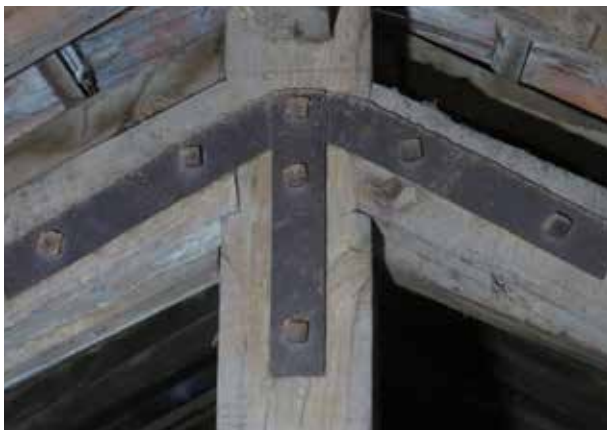
Nó com reforço metálico
