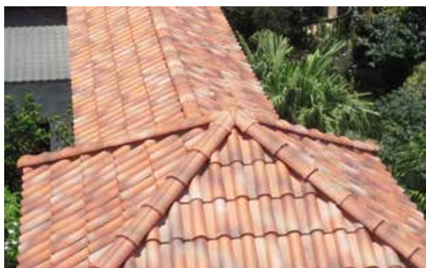
Telhado com telha lusa
