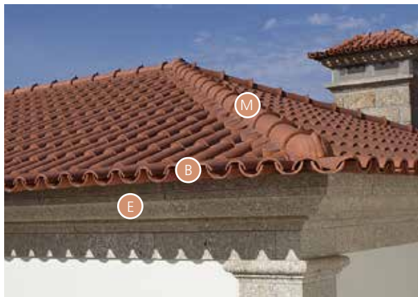
Cimalha (E), beirado (B) e rincão ou guieiro (M)
