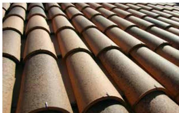
Pormenor de fixação de telha canudo
