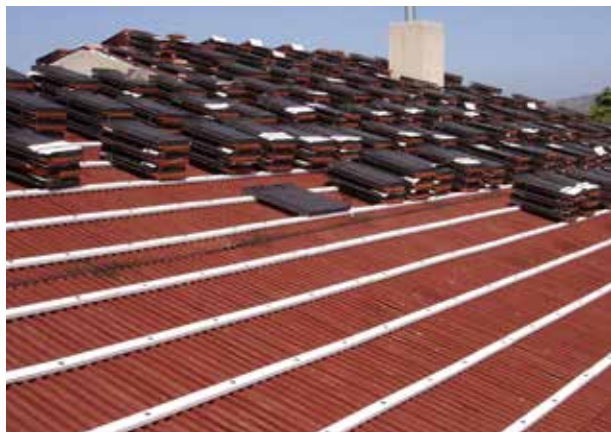
Aplicação de subtelha, como complemento de estanquidade, sob telha cerâmica
