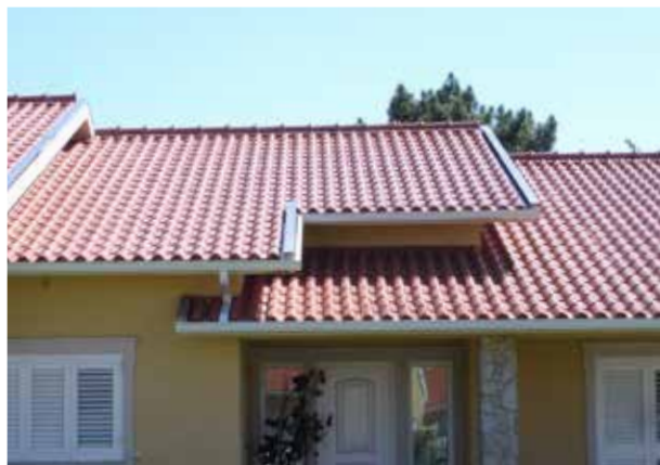
Remates do telhado com parede não emergente (bordos) por telhões de cumeeira ou rufagem
