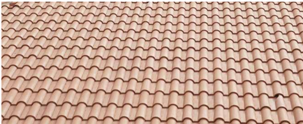
Aplicação da telha lusa
