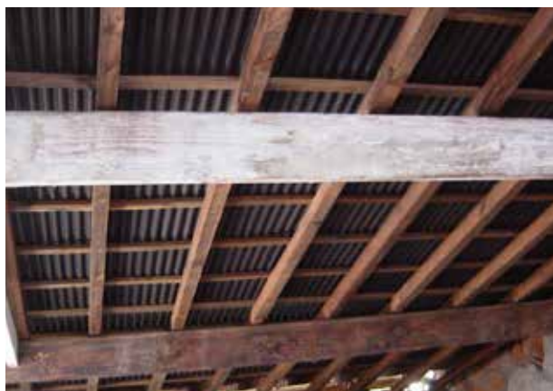
Aplicação de subtelha sobre estrutura secundária
