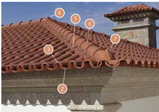
Pormenor de beirado com cimalha
