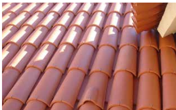
Vista geral de telhado com telha romana
