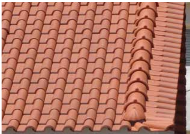
Revestimentos em zona corrente (telha lusa e telha marseilha)
