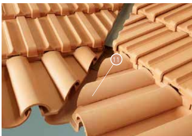
Pormenor de laró com terminação em canto recolhido de beirado (interior)
