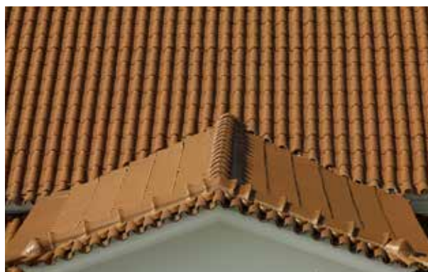
Pormenor de telhado com telha lusa
