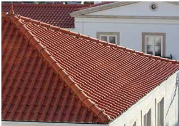
Rincões e larô nas bissetrizes dos ângulos do telhado
