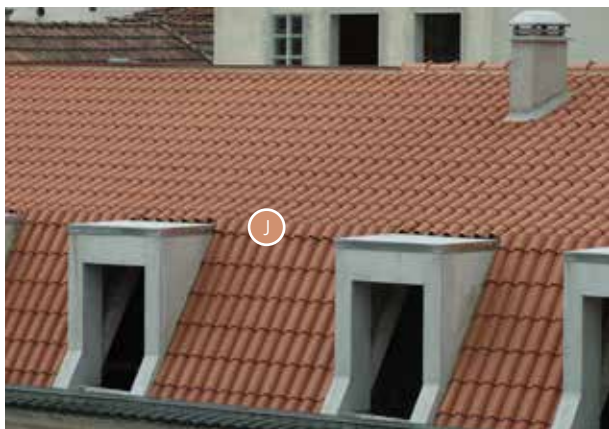
Quebra de mansarda (J)
