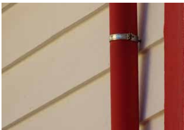
Fixação à parede e proteção de tubo de queda, junto à rua
